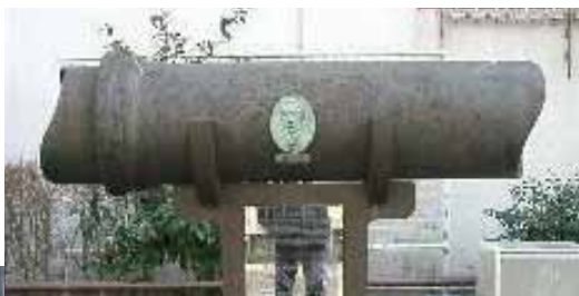
写真右 【鑄鉄製水道管】 当時使用したイギリス製水道管。
